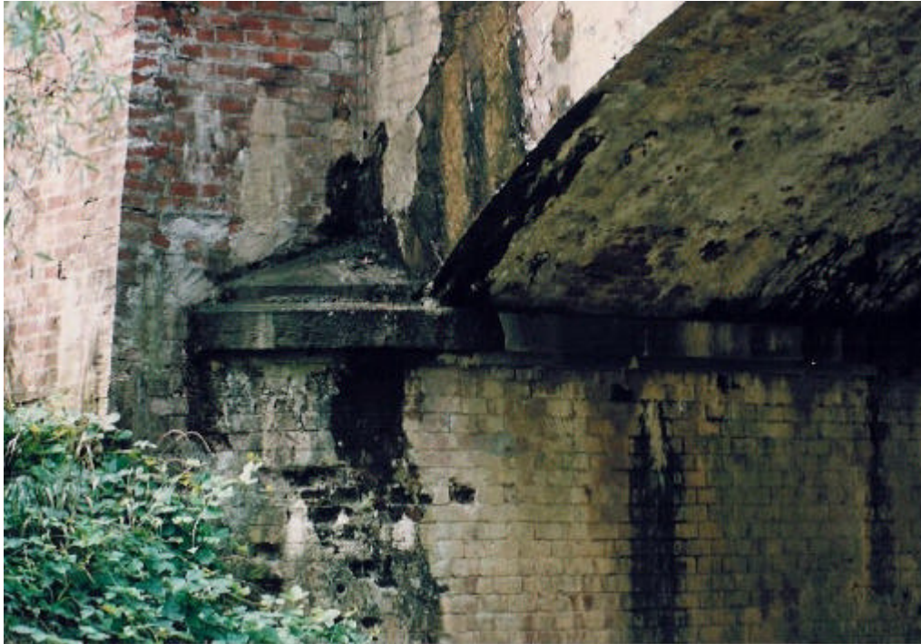
Figura 16. Spalla con mezzi rostri, ponte Meletta - linea Trofarello-Cuneo, progr. 19+256 (Archivio FS-TO)
