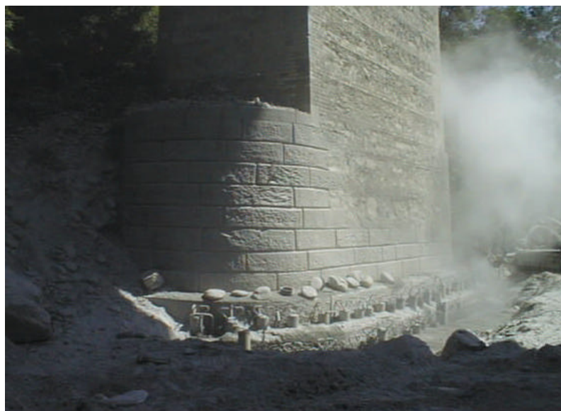
Figura 6 Particolare della sommità della palancoolata di protezione, viadotto Stura – linea Cuneo-Cuneo Gesso, progr. 5+260 (Archivio FS-TO)
