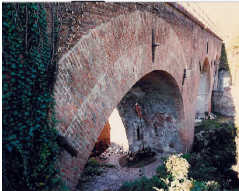
Figura 38. Arcata a due strati - linea Savona-Carmagnola, progressiva 44+477 (Archivio FS – TO)
