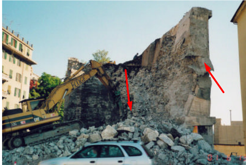
Figura 42. Demolizione del ponte del raccordo ferroviario con la zona industriale di Genova Cornigliano: si osservi come il rinfiango sia stato realizzato mediante un conglomerato molto consistente (demolito con l'ausilio del martellone) e come i timpani siano strutture massicce in contraddizione con il ridotto spessore dell'arcata su cui sono impostati.
