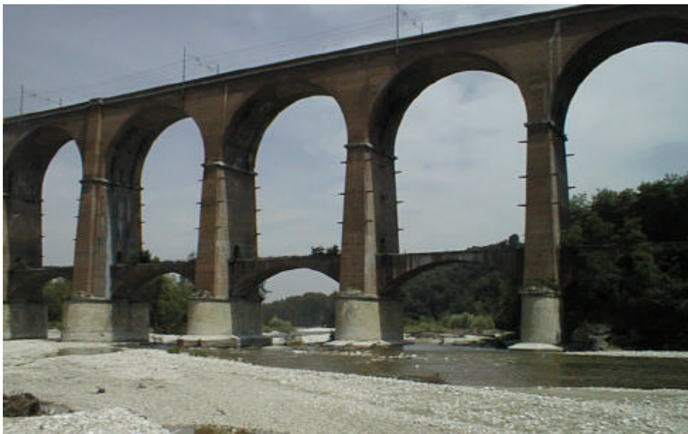
Figura 25. Viadotto Stura- linea Fossano-Ceva, progr. 2+606 (archivio FS- TO)
