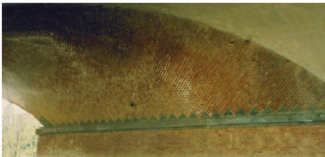
Figura 3 Tessitura elicoidale, ponte Bobore - linea Torino-Genova, progr. 54+797 (Archivio FS - TO)
