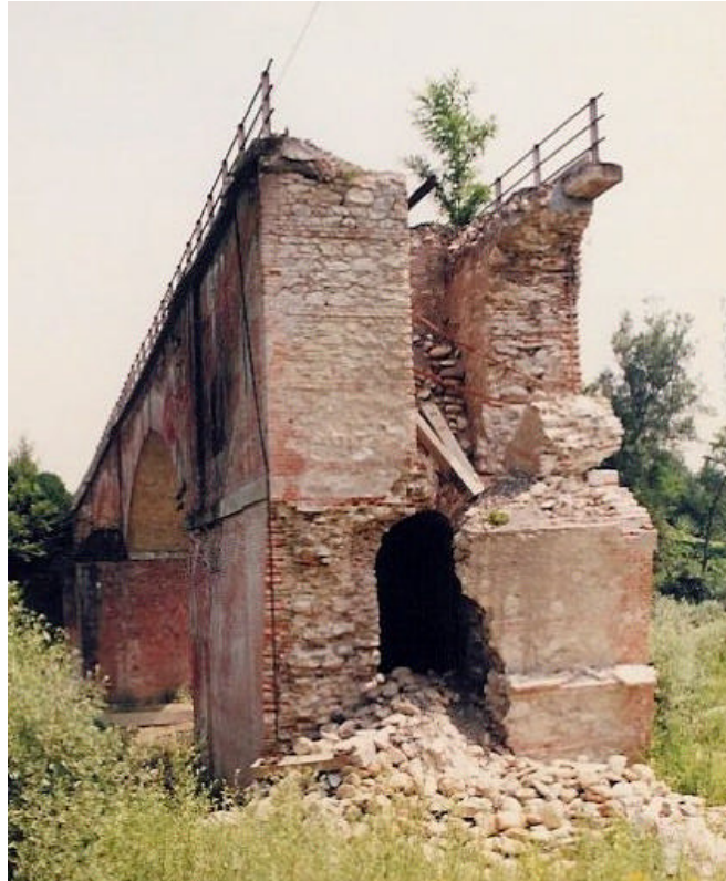
Figura 18. Particolare di pila - linea Savona-Carmagnola, progressiva 52+133 (Archivio FS -TO). Si osservi, in questo specifico esempio, come i timpani siano particolarmente spessi, costituiti da muratura in pietrame listata e la parte centrale dell'arcata non sia interessata da alcuna forma di riempimento.
