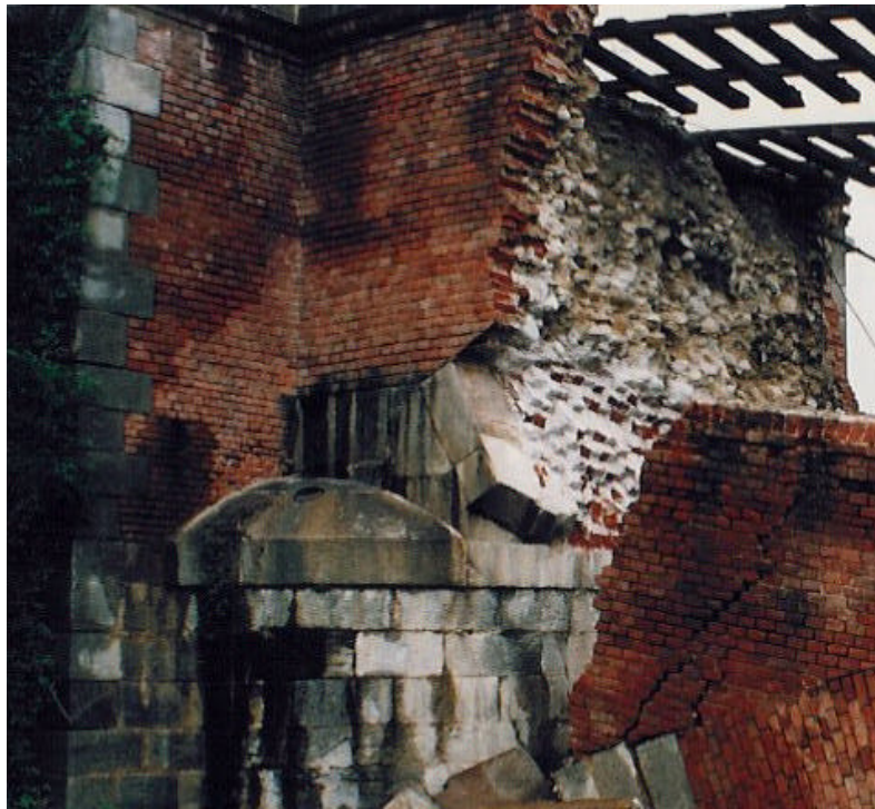
Figura 12. Particolare dell'imposta in pietra - Ponte Gesso linea Cuneo-Mondovì, progr. 0+229, (Archivio FS). Si osservi la parte crollata dell'arcata: non solo le reni ma tutta la parte iniziale della volta parrebbe essere costituita da blocchi di pietra squadrata, ma in realtà questo si realizza solo nella parte esterna della volta. Si osservi anche il rinfianco, costituito da un conglomerato con inerti di varia pezzatura.
