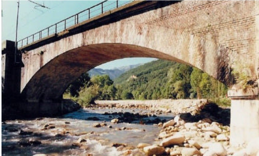
Figura 4 Arco a sesto ribassato - linea Cuneo-Limone, ponte Vermenagna, progr. 19+403 (Archivio FS-TO).
