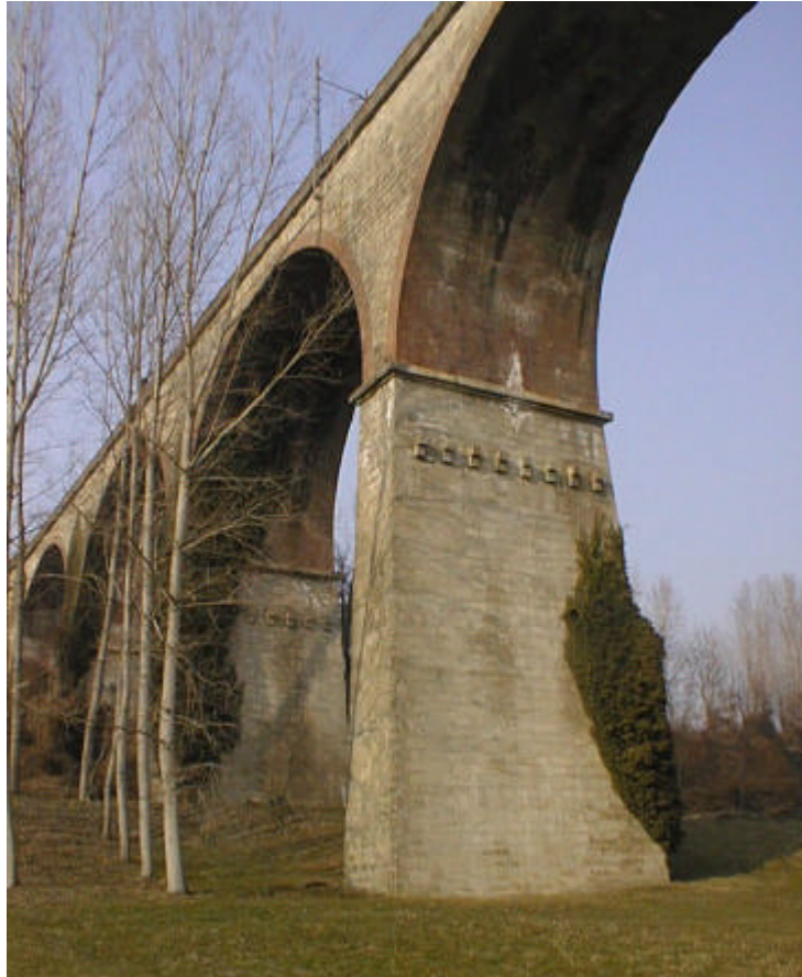
Figura 21 Pila del viadotto Pesio - linea Fossano-Ceva, progr. 14+200 (Archivio FS – TO). Poco sotto l'imposta dell'arcata si osservano delle mensole in pietra, appoggi della centinatura in fase di costruzione.
