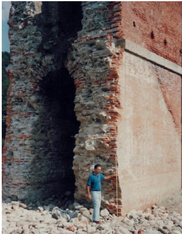
Figura 2 Particolare di pila da viadotto - linea Savona-Carmagnola, progressiva 52+133 (Archivio FS-TO)
