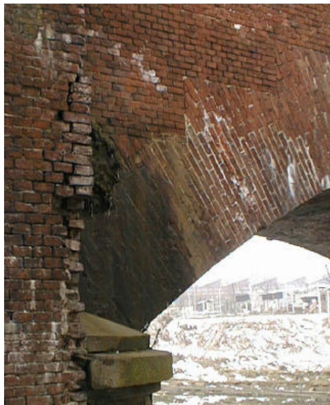
Figura 32. Estradosso dell'arcata scalettato - ponte Sangone - linea Torino-Genova, progr. 6+690 (Archivio FS - TO).
