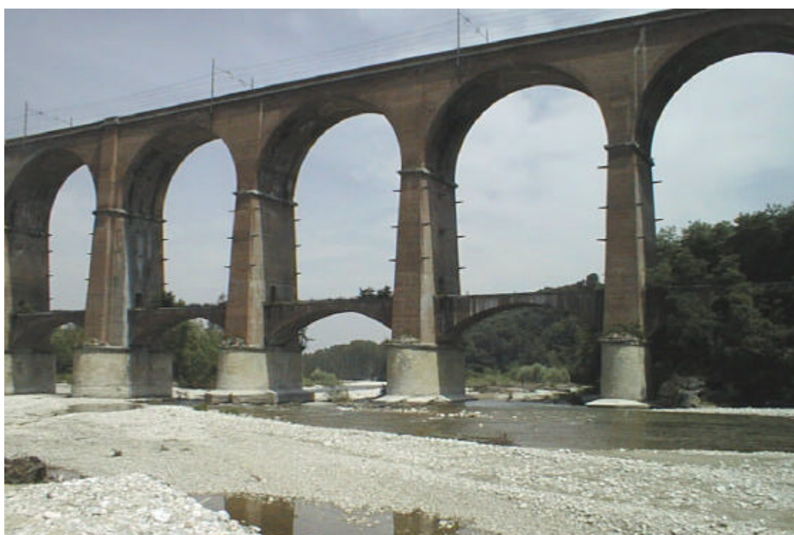
Figura 7 Viadotto Stura - linea Fossano-Ceva, progr. 2+606 (Archivio FS-TO).
