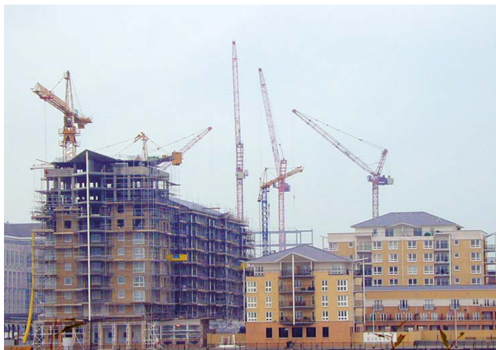
Fig. 9 Interferenza tra gru.
