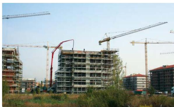
**Fig. 1** Lavorazioni di cantiere: possibili interferenze tra gru.
